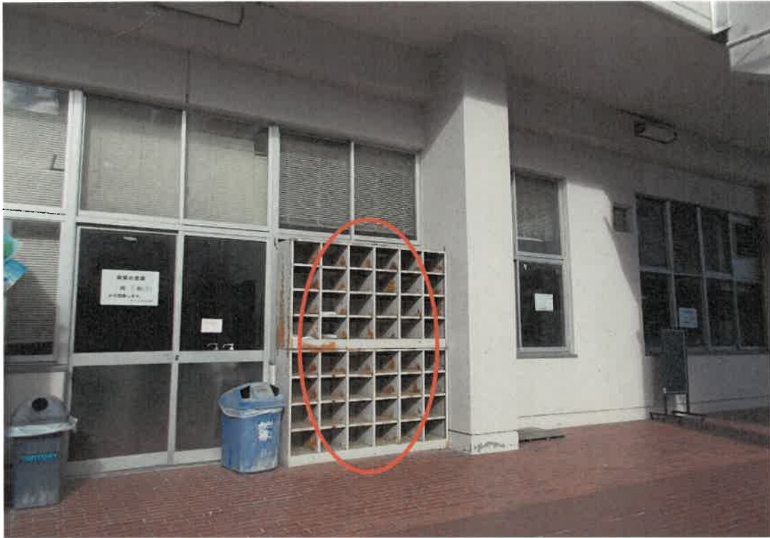
既存靴箱位置に設置（靴箱は本校が撤去）
